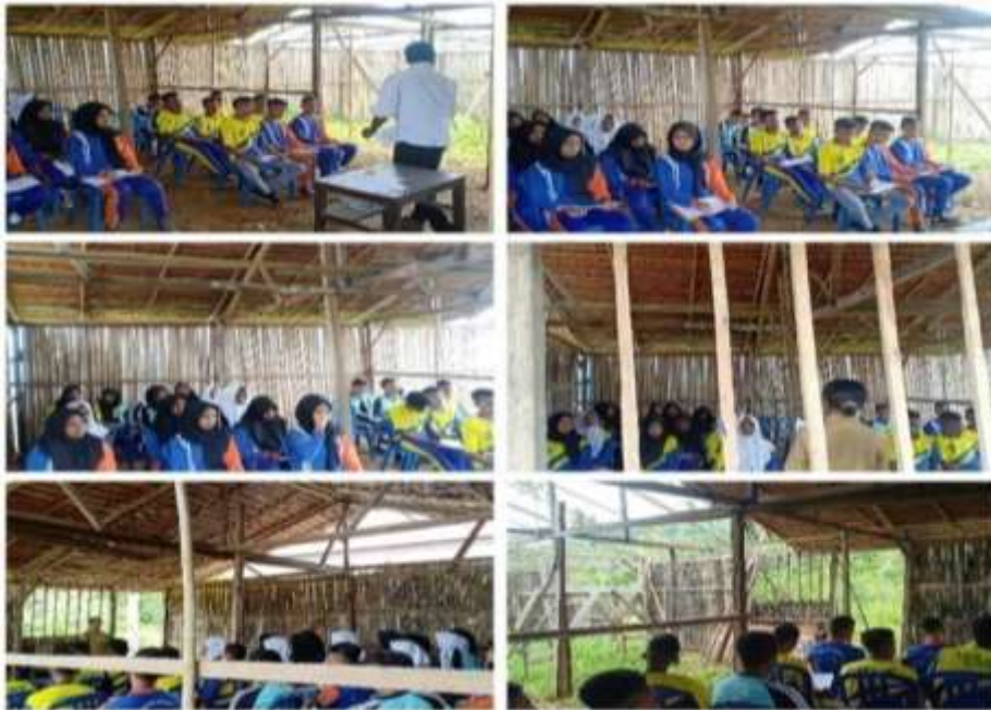
Gambar 3. Pemanfaatan Bangunan RKB dari Gabah – Gabah untuk Proses Belajar Mengajar di SMAS Persiapan Tamher Warat
