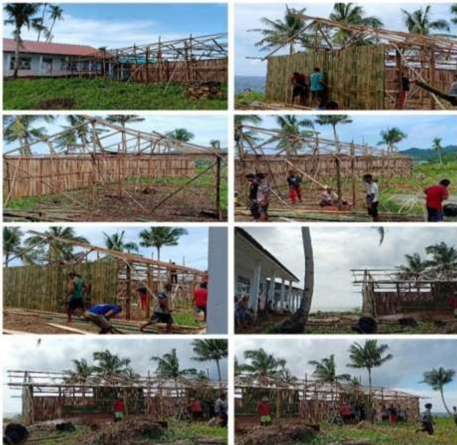
Gambar 2. Proses Pembangunan 4 RKB (Ruang Kelas Belajar) dari Gabah-Gabah di SMAS Persiapan Tamher Warat
