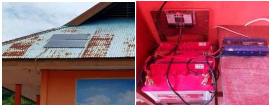
Gambar 15. PLTS 2 (PV 200WP; baterai lifepo4 80ah, 12V)
