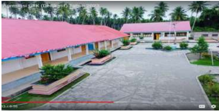
Kondisi Sekolah Setelah di Rehabilitasi
