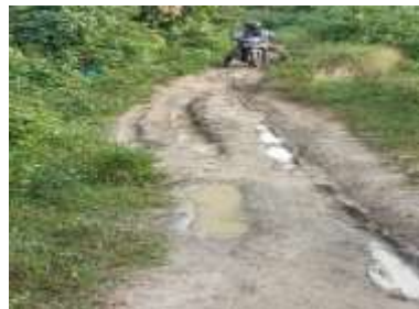
Kondisi jalan setapak
