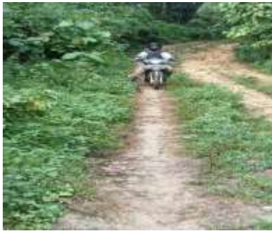
Kondisi jalan yang rusak
