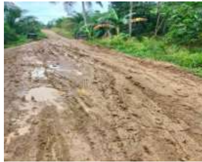
Kondisi jalan berlumpur
