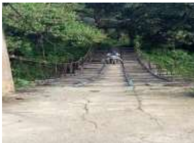
Kondisi jembatan gantung darurat sepanjang 45 meter.
