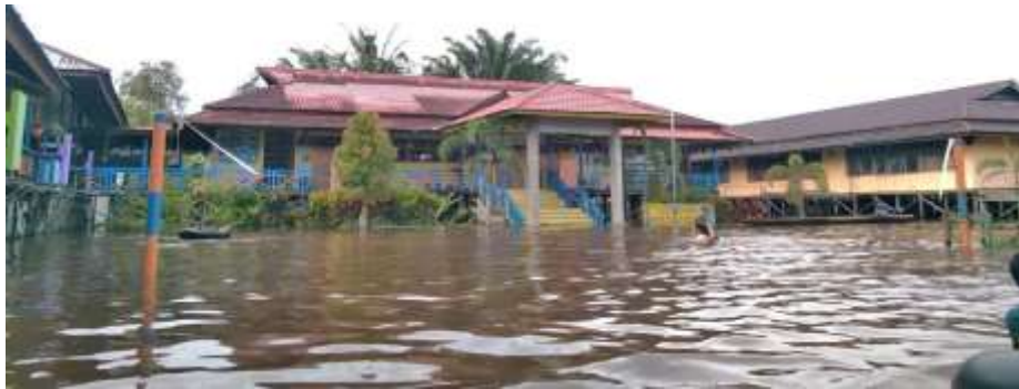
Kondisi banjir terjadi setiap tahun
